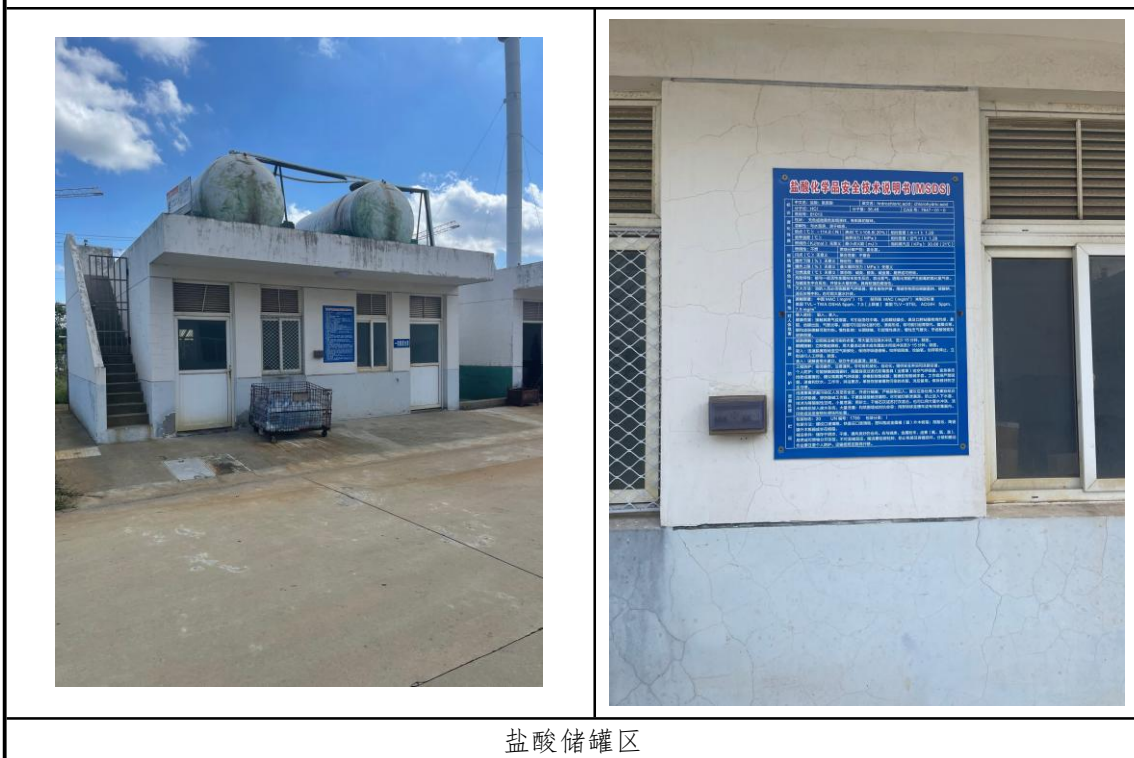
盐酸储罐区现场踏勘图
