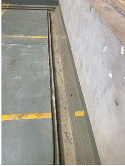
危废仓库外部图片
